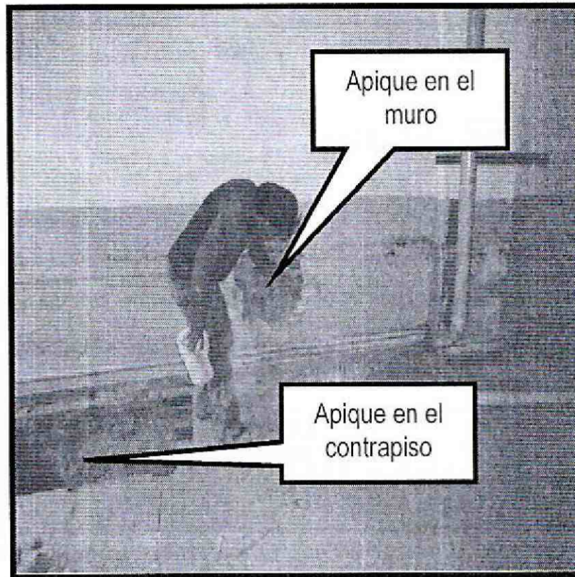
Fotografía 5 Apique en el contrapiso junto al muro de cerramiento del costado occidental del predio de la Carrera 9 No 10-37, en Sector Catastral Centro Administrativo de la Localidad de La Candelaria.
