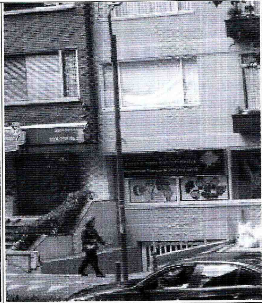
Fotografía 2. Vista frontal del predio de la Carrera 11 No. 96 - 05 Edificio Montelibano
