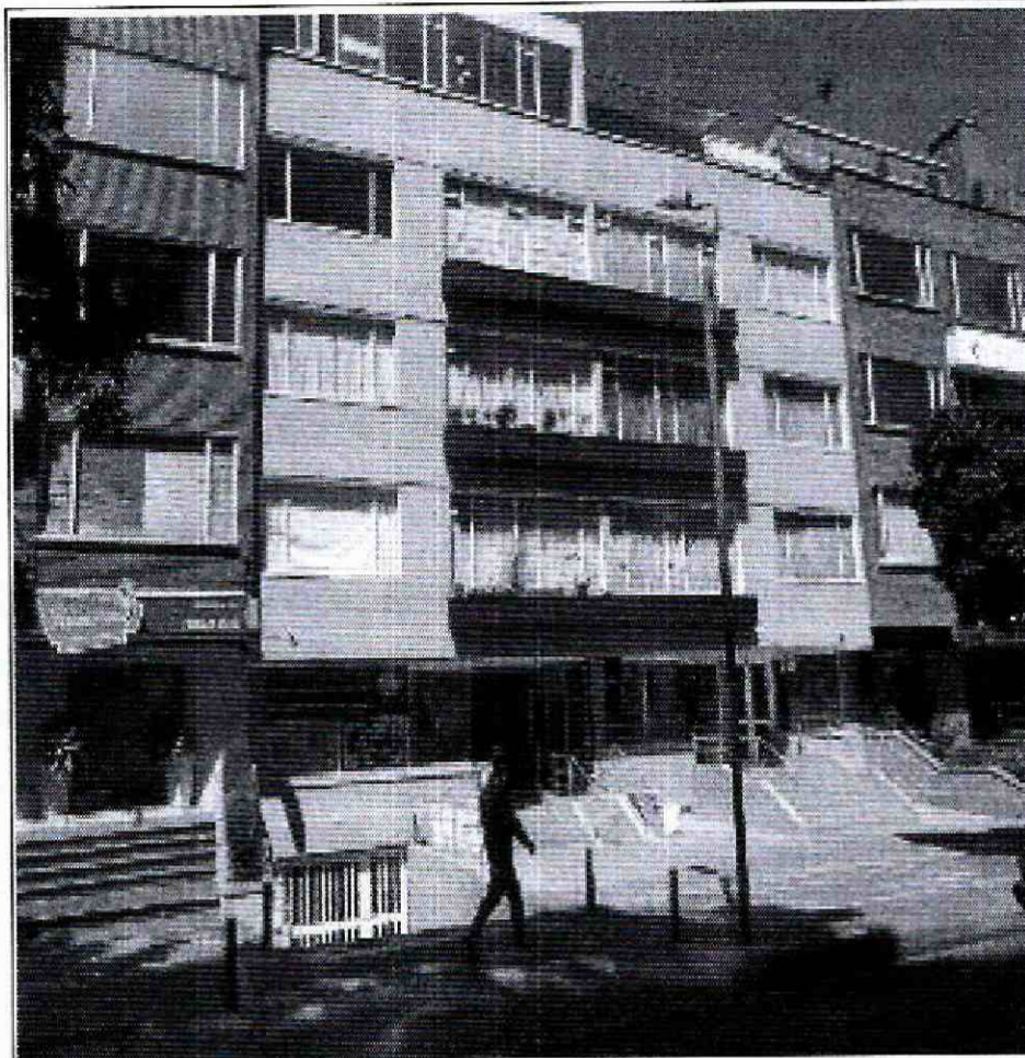
Fotografía 1. Vista frontal del predio de la Carrera 11 No. 96 - 05 Edificio Montelibano
