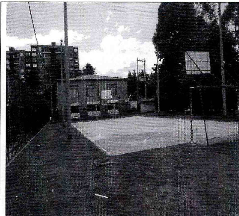
Foto No 3: Vista General del salón comunal de la Agrupación de Vivienda Arboleda de la Campiña I PH.
