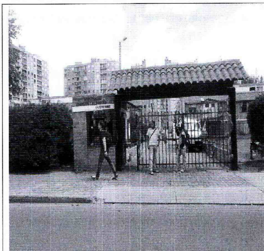
Foto No 1: Fachada de la entrada principal de la Agrupación de Vivienda Arboleda de la Campiña I PH.
