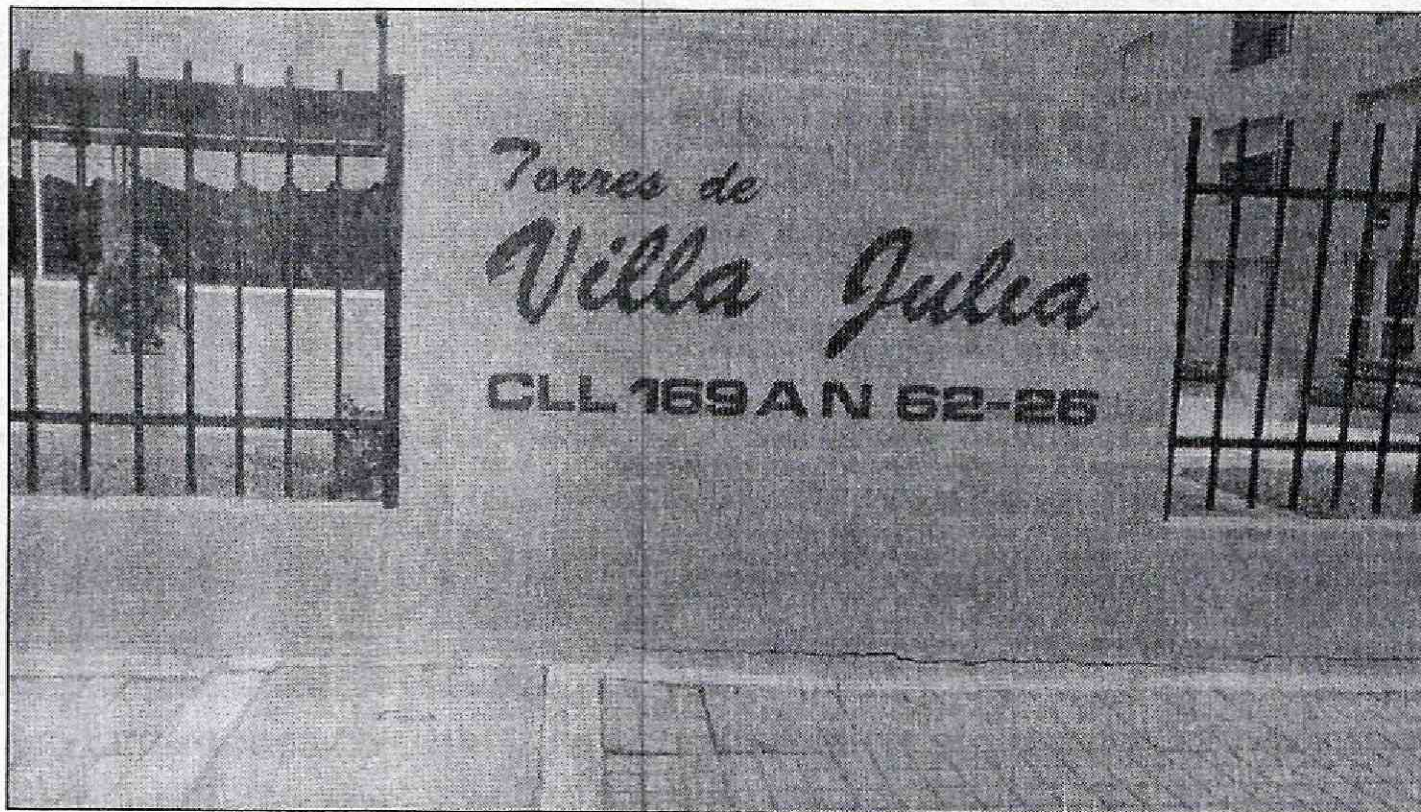
Fotografía 1. Fachada principal del Conjunto Residencial Torres de Villa Julia emplazado en el predio de la Calle 169 A No. 62-26 en el Sector Catastral Portales del Norte, de la Localidad de Suba.
