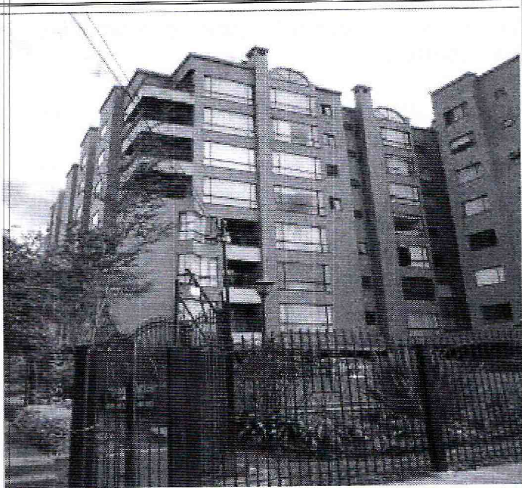
Fotografía 1. Vista del Conjunto Residencial Oikos ubicado en el predio de la Carrera 56 A No. 137 – 74, en el Sector Catastral San José del Prado de la Localidad Suba
