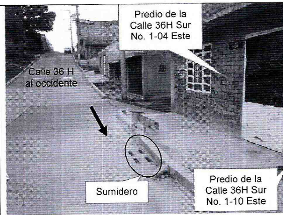
Fotografía 9. Vista de la vía Calle 36 H al occidente, con pendiente cercana al 15%, parte de la escorrentía se evacua al sumidero.
