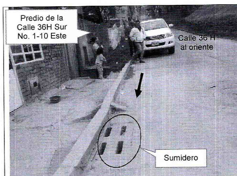
Fotografía 8. Vista de la fachada de la vivienda de la Calle 36 H Sur No. 1-10 Este y la vía Calle 36 H al oriente, con pendiente cercana al 8%, la cual evacua la escorrentía al sumidero.
