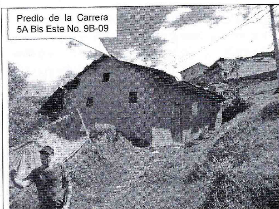
Fotografía 3. Vista de la fachada del predio de la Carrera 5A Bis Este No. 9B-09, en el Barrio Egipcio de la Localidad de Santa Fe.
