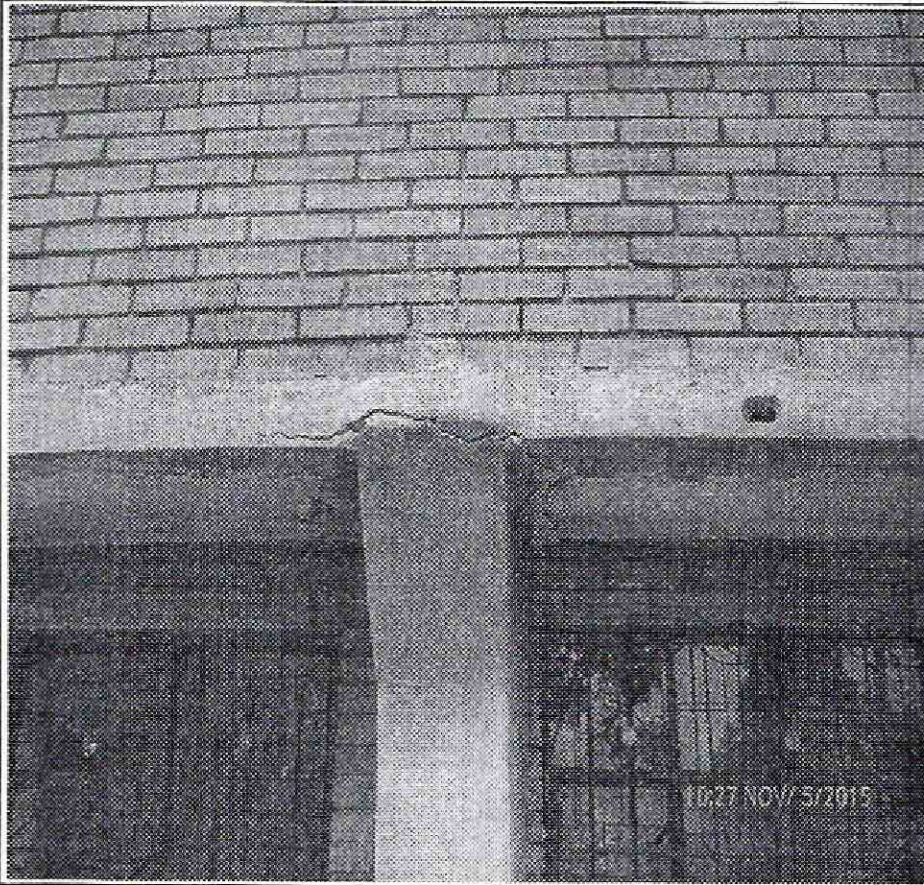
Fotografías 5 y 6. Se observan grietas en el muro de cerramiento del predio de la Calle 37 Sur No 1-09, barrio La Colmena de la Localidad San Cristóbal.
