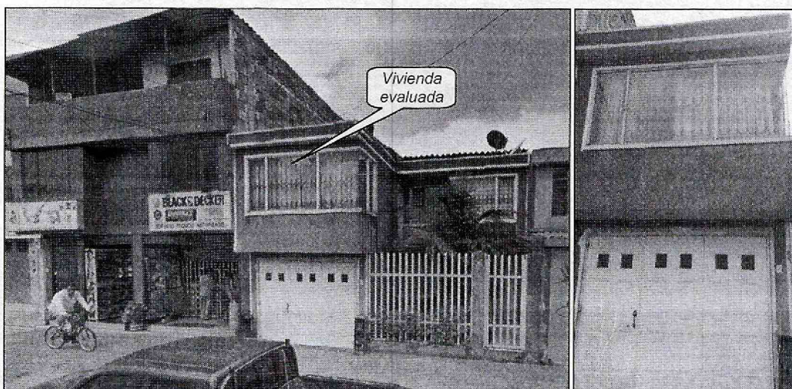
Fotografía 1 y 2. Fachada principal de la vivienda emplazada en el predio de la Calle 75 No. 94-55, en el Sector Catastral Florencia, de la Localidad de Engativá.
