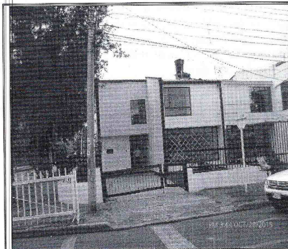
Fotografía 1. Vista de la vivienda ubicada en el predio de la Carrera 54 A No. 59-05, en el Sector Catastral Pablo VI Norte de la Localidad Teusaquillo. Se observa que presenta dos (2) niveles.
