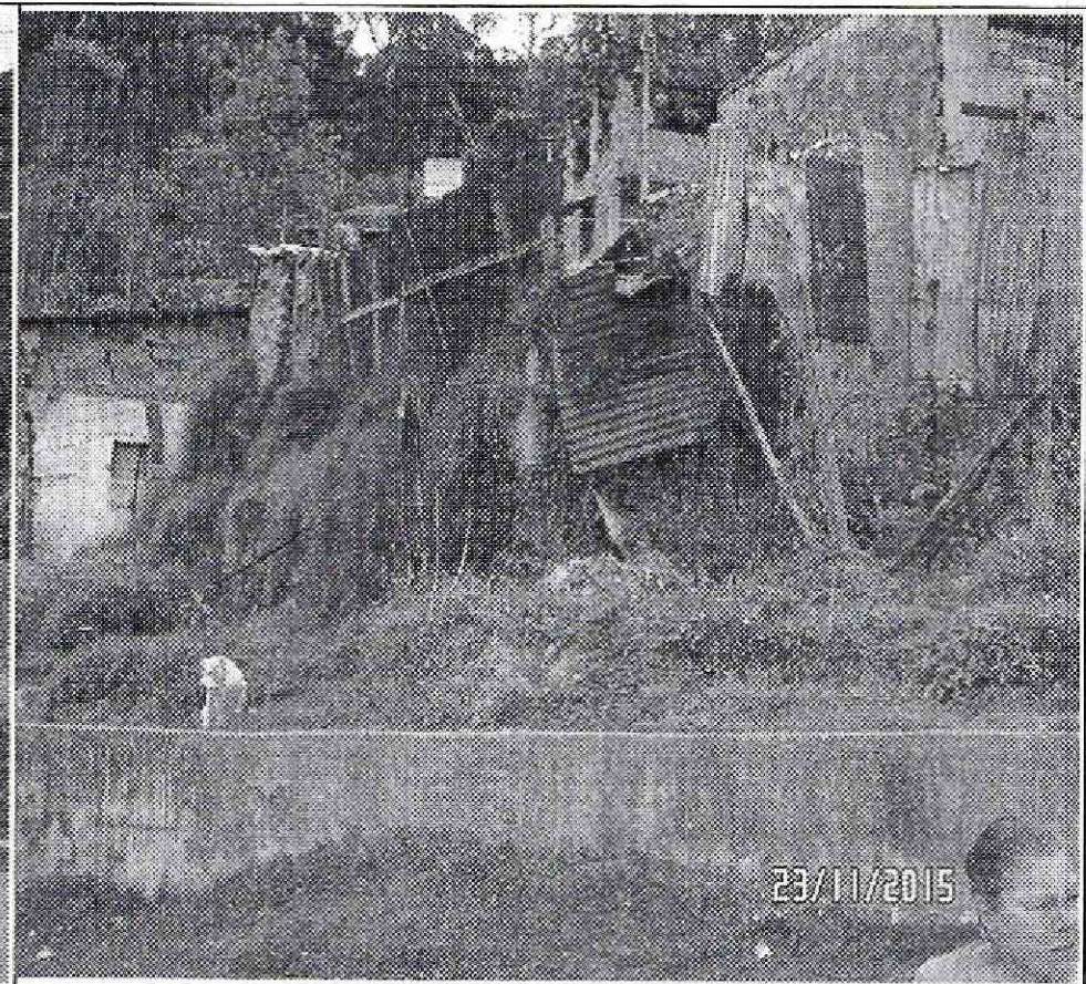
Fotografías 5 y 6. Zona de transición entre el muro de contención y la vivienda de la Carrera 7A Este No 9B-41, existe un lote donde se observan ondulaciones en terreno posiblemente asociadas a las labores de excavación realizadas para la adecuación del muro de contención y su posterior emplazamiento.
