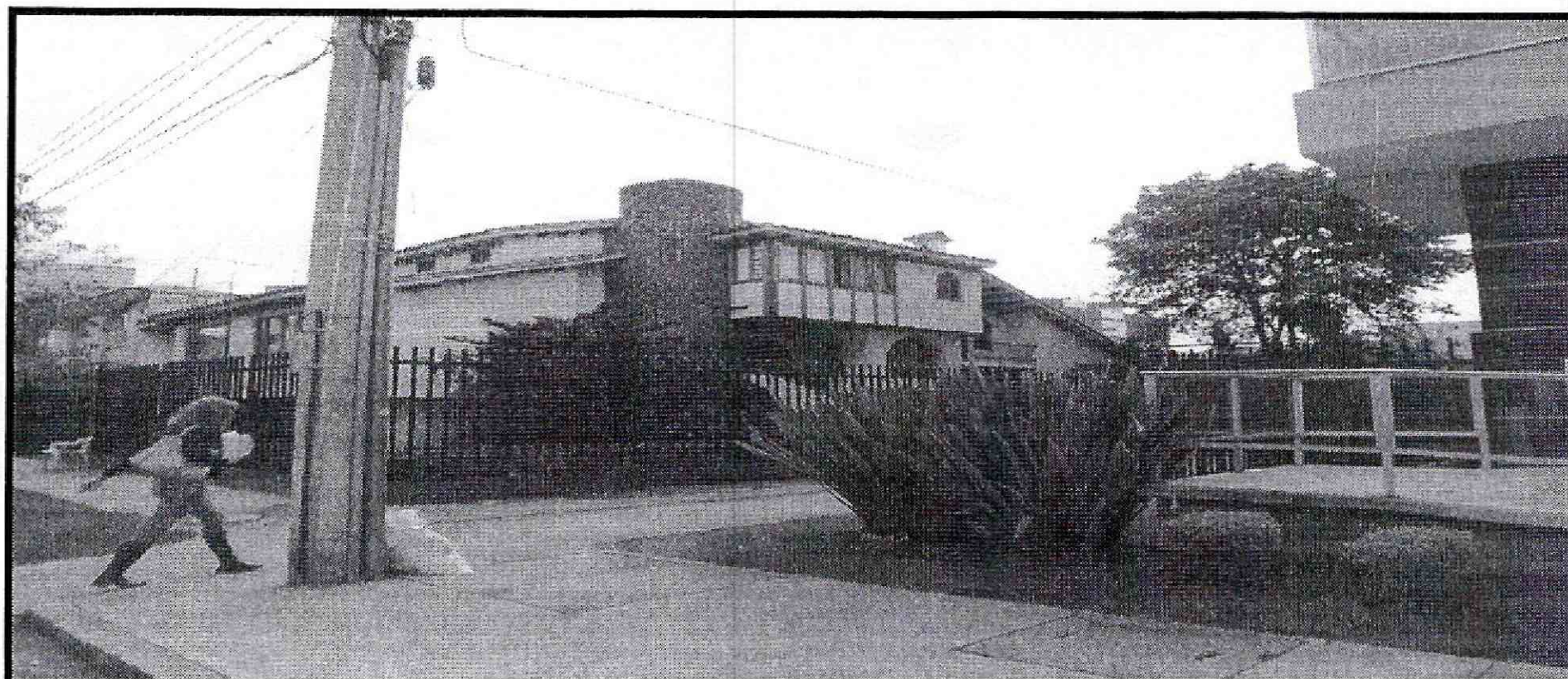
Fotografía 1. Vistas general de la fachada de predio ubicado en la Carrera 36 No 56 A 67, en el Sector Catastral Nicolás de Federmán de la Localidad de Teusaquillo.
