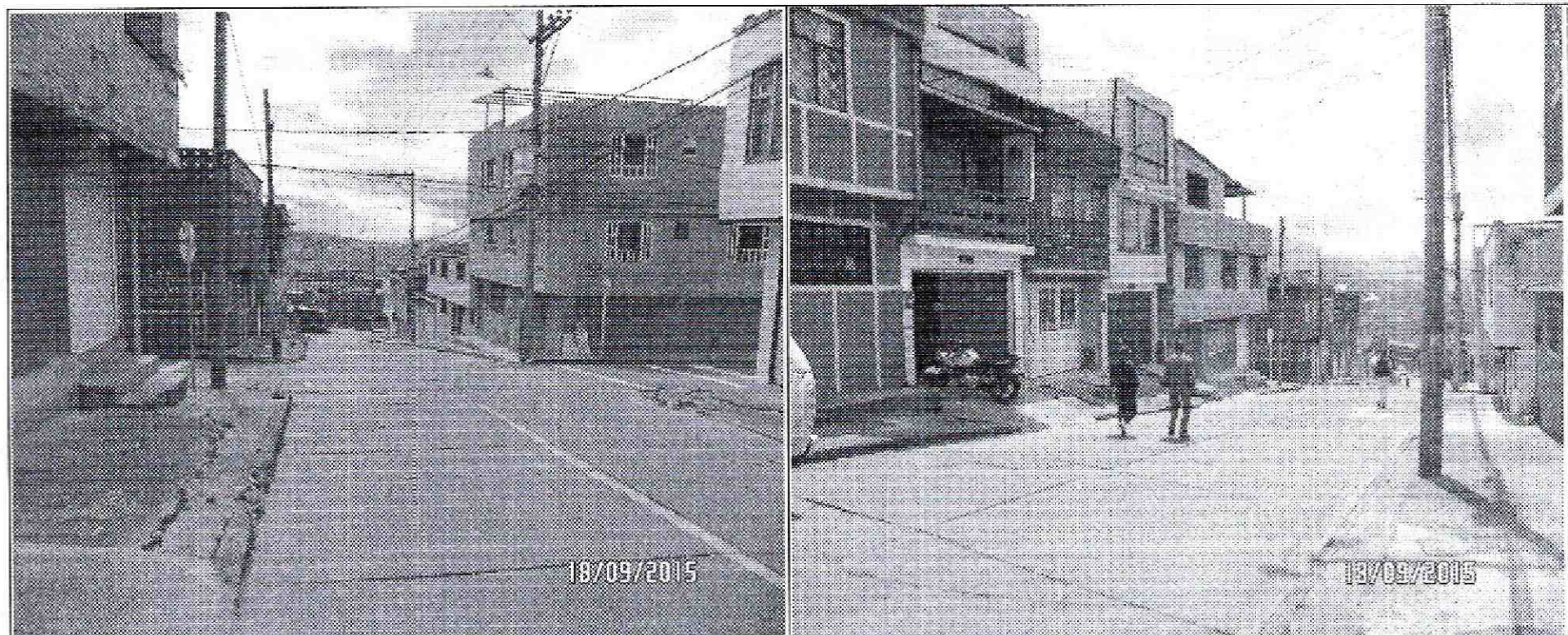
Fotografía 1 y 2. Sector de la Calle 43A Sur a la altura de la Carrera 11 Este y 11B Este, se identifica un tramo de vía vehicular de ancho cercano a los 6 metros en pavimento rígido.
