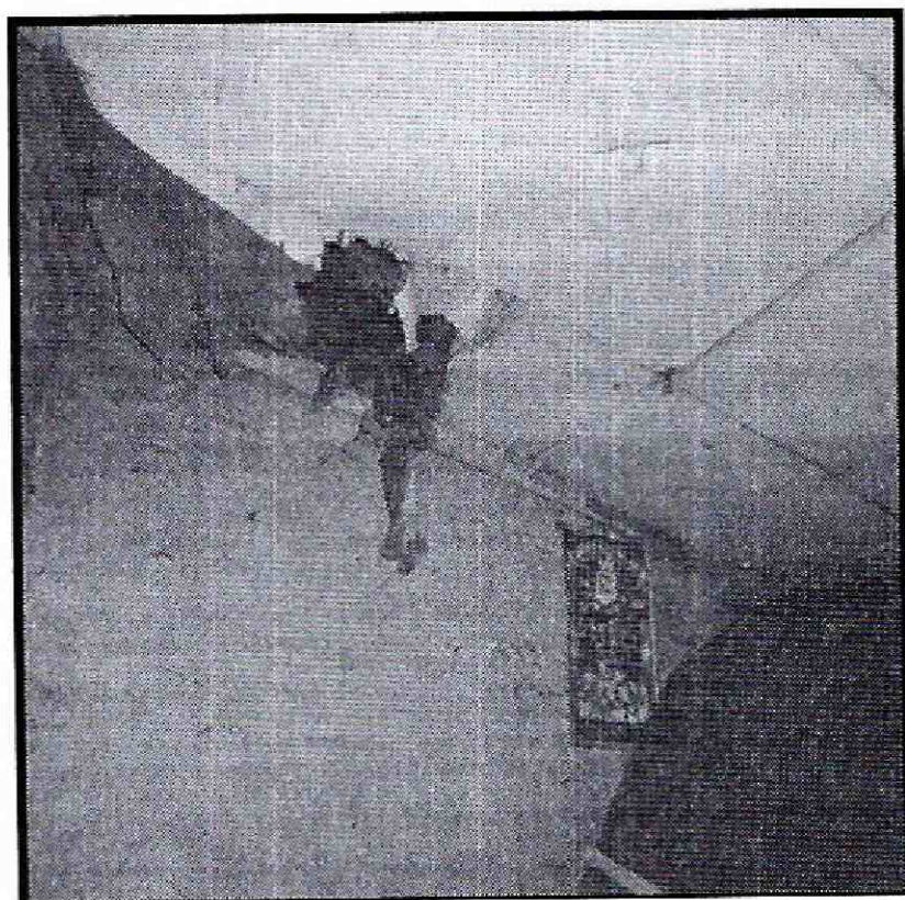
Fotografías 2 y 3. Desprendimientos de las láminas de aglomerado de los cielorrasos de las dos habitaciones, en la vivienda ubicada en el predio ubicado en la Diagonal 16 A No 100-27, en el Sector Catastral La Laguna, de la Localidad de Fontibón.
