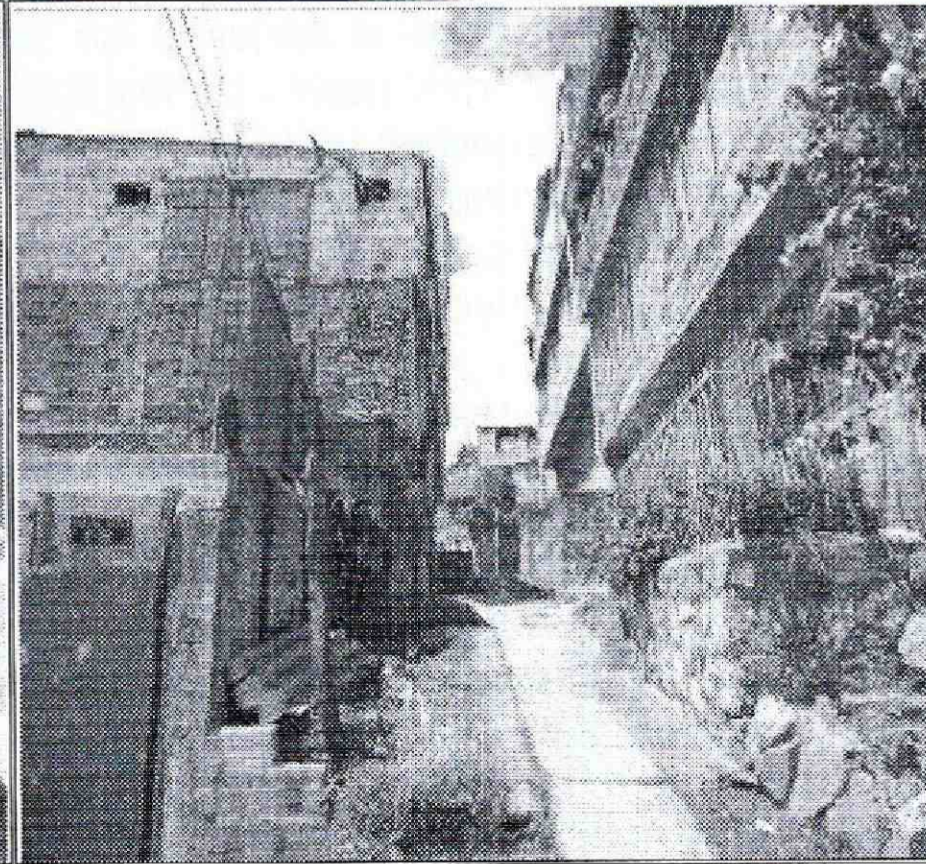
Foto No. 4 Vía de acceso al sector del predio de la Diagonal 68 G Sur No. 1C – 16 Este
