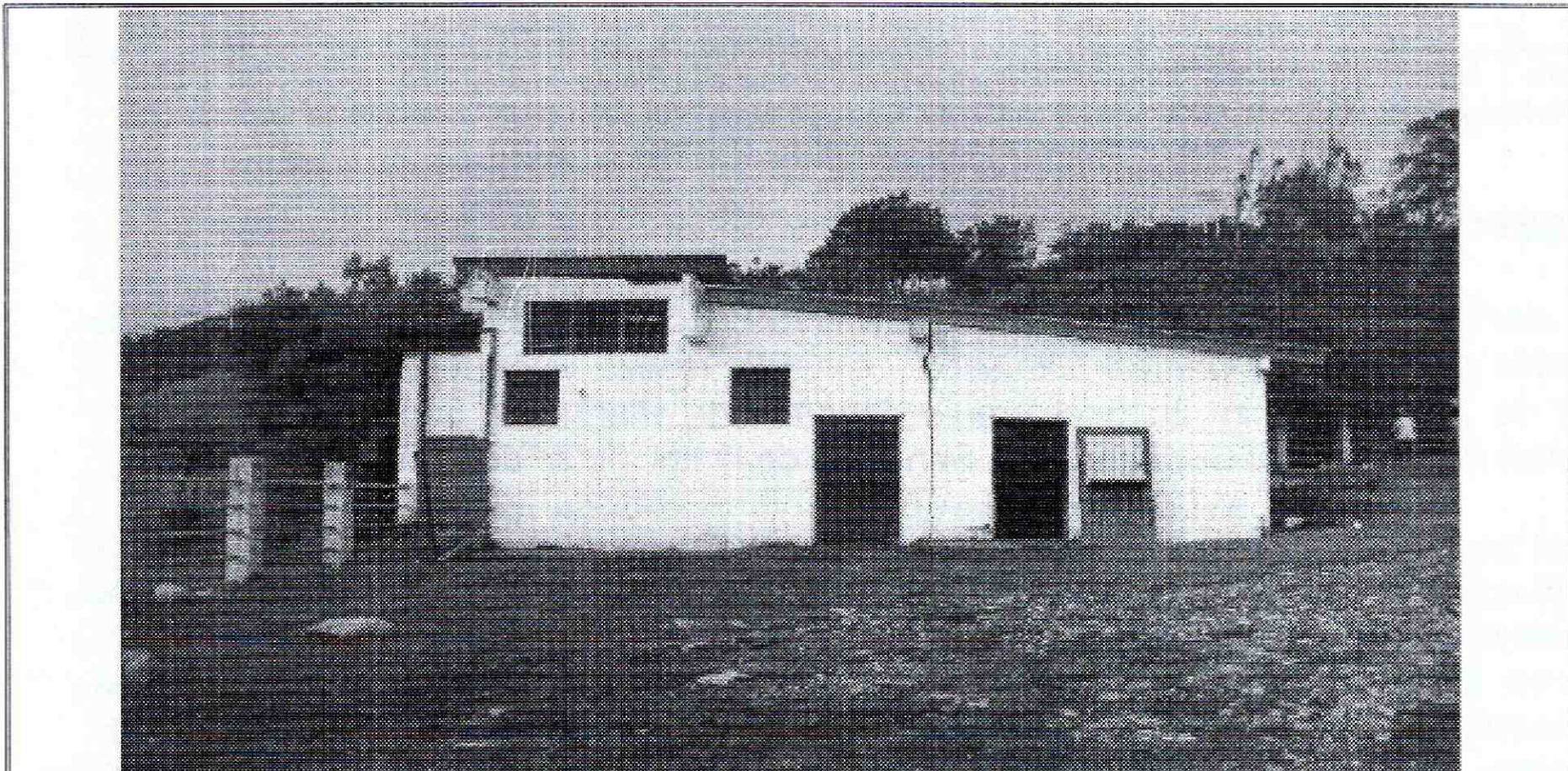
Foto No. 1. Vista frontal del predio denominado planta de sacrificio del centro poblado La Unión del Corregimiento San Juan de la Localidad de Sumapaz
