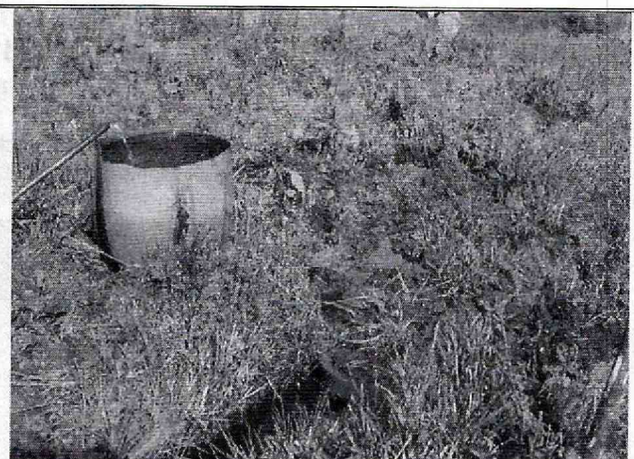
Foto No. 6. Suelo saturado en el contorno de la vivienda.
