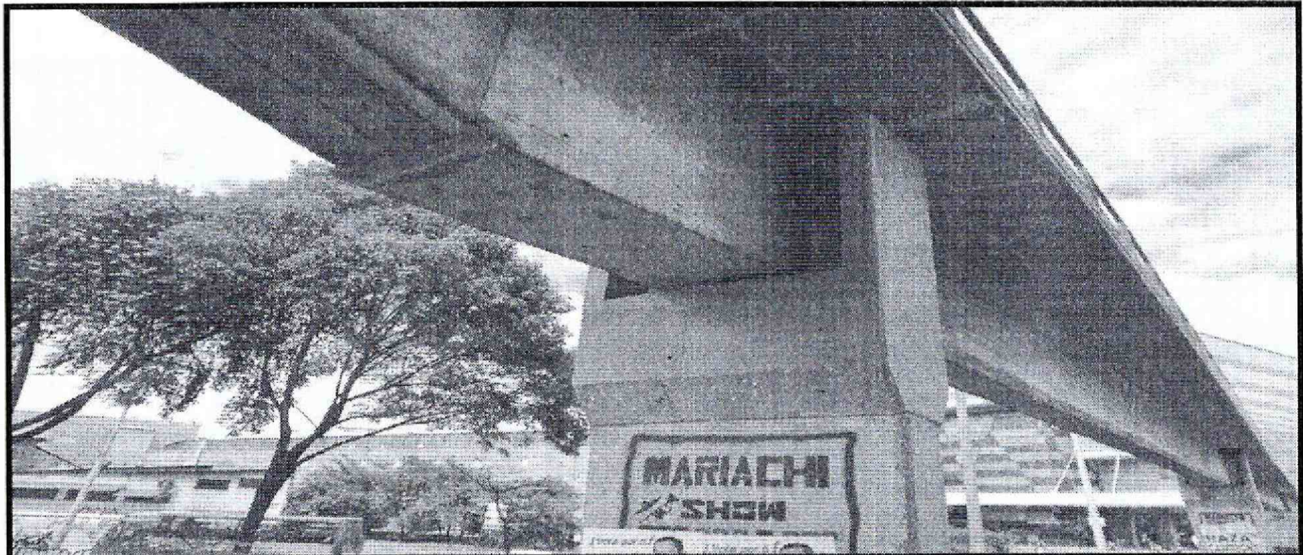
Fotografía 6. Bloque central del puente peatonal
