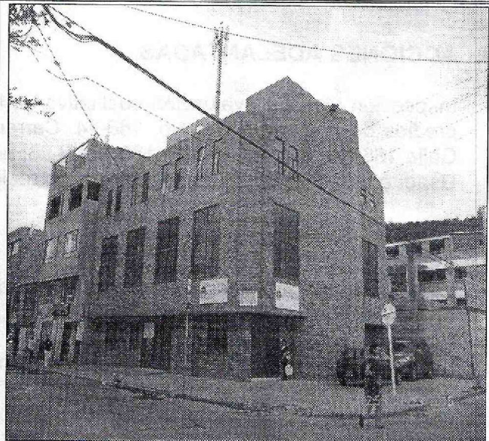
Fotografía 6. Vista de la iglesia cristiana, ubicada en el predio de la Calle 186 No. 8-96, en el Sector Catastral Tibabita de la Localidad Usaquén. Se observa que la antena se ubica en la parte posterior de la mencionada iglesia.
