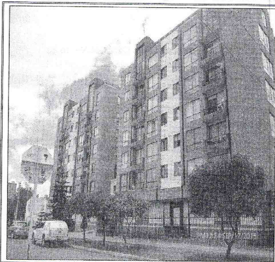
Fotografía 1. Conjunto residencial Portofino, ubicado en el predio de la Carrera 13 No. 147-26, en el Sector Catastral Caobos Salazar de la Localidad Usaquén. Se observa que presenta ocho (8) niveles.
