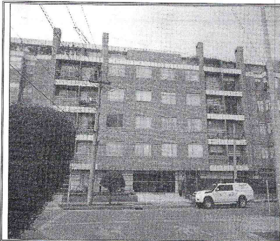
Fotografía 1. Edificio Antares, ubicado en el predio de la Calle 144 No. 18-60, en el Sector Catastral Los Cedros de la Localidad Usaquén. Se observa que presenta seis (6) niveles.
