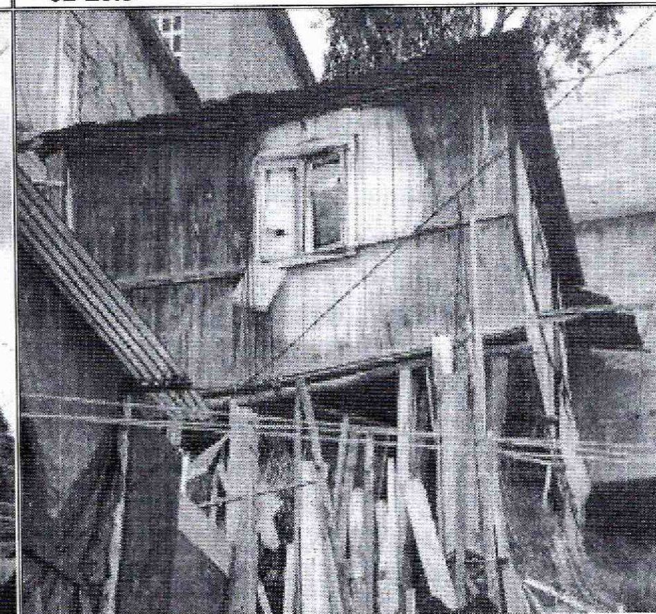
Foto No. 4 Palafitos sobre los que se encuentra soportada la vivienda de la Vista del predio de la Calle 3 A Bis No. 5 B - 32 Este
