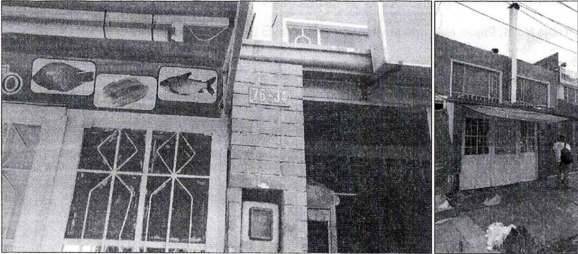
Fotografía 9 y 10. Vista de la edificación emplazada en la Calle 64 F No. 76-34, en el Sector Catastral El Real, de la Localidad de Engativá, donde no se observan afectaciones
