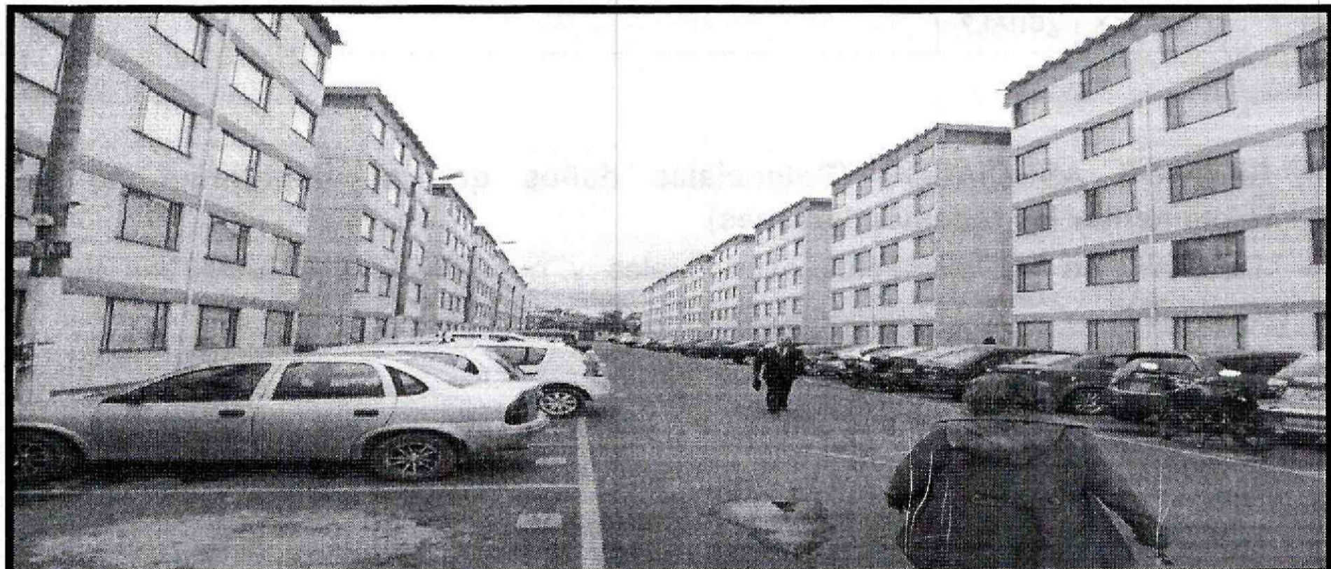
Fotografía 1. Vista general del Conjunto Residencial Los Cristales etapa V y VI, en el Sector Catastral Providencia Occidental, de la Localidad de Kennedy.
