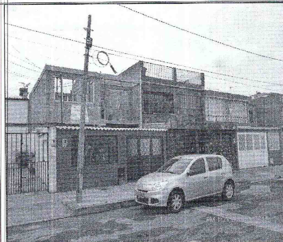
Fotografía 5. Obras de ampliación que se desarrollan en uno de los predios del sector evaluado en la Carrera 76 A y la Carrera 86, entre la Calle 90 y la Calle 90 A, en el Sector Catastral La Serena de la Localidad Engativá.
