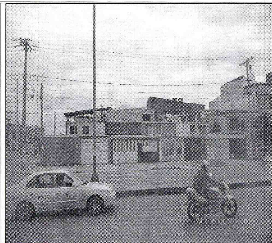
Fotografía 8. Tipología inicial con que fueron concebidas las viviendas del sector, la cual es de dos (2) niveles, con zona de antejardín y patio posterior. Se observa las viviendas aledañas con ampliaciones.
