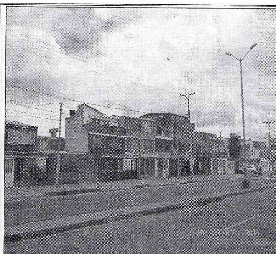
Fotografía 2. Tipología estructural actual de las viviendas del sector evaluado en la Carrera 76 A y la Carrera 86, entre la Calle 90 y la Calle 90 A, en el Sector Catastral La Serena de la Localidad Engativá.
