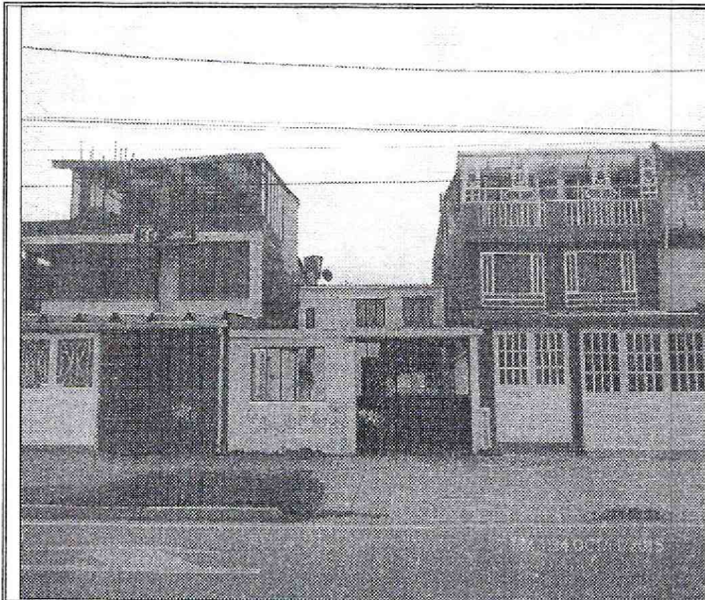
Fotografía 7. Tipología inicial con que fueron concebidas las viviendas del sector, la cual es de dos (2) niveles, con zona de antejardín y patio posterior. Se observa las viviendas aledañas con ampliaciones.
