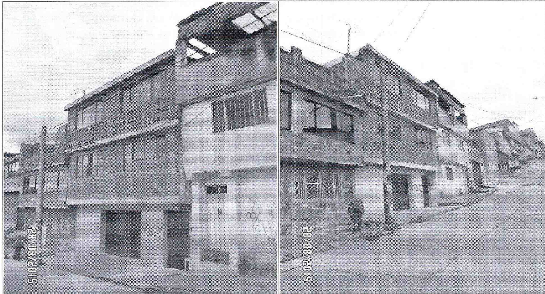
Fotografía 1 y 2. Sector donde se localiza el predio de la Carrera 6 Este No 36H-20 Sur, barrio San Vicente Sur Oriental de la Localidad de San Cristobal.
