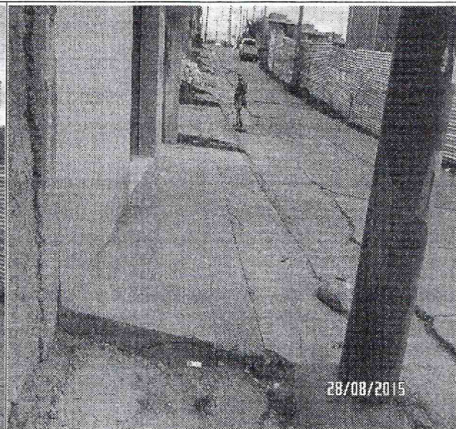
Fotografía 5 y 6. Vía de la carrera 6 Este, la cual corresponde a una estructura en pavimento rígido se observan grietas longitudinales sobre 6 losas de aberturas cercanas a los 3 centímetros y una grieta en bloque al costado oriental del proyecto urbanístico Balcones de Provenza.
