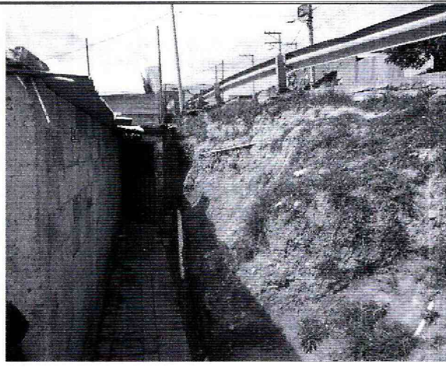
Foto No. 4. Talud de corte sobre el costado occidental de la vivienda evaluada.
