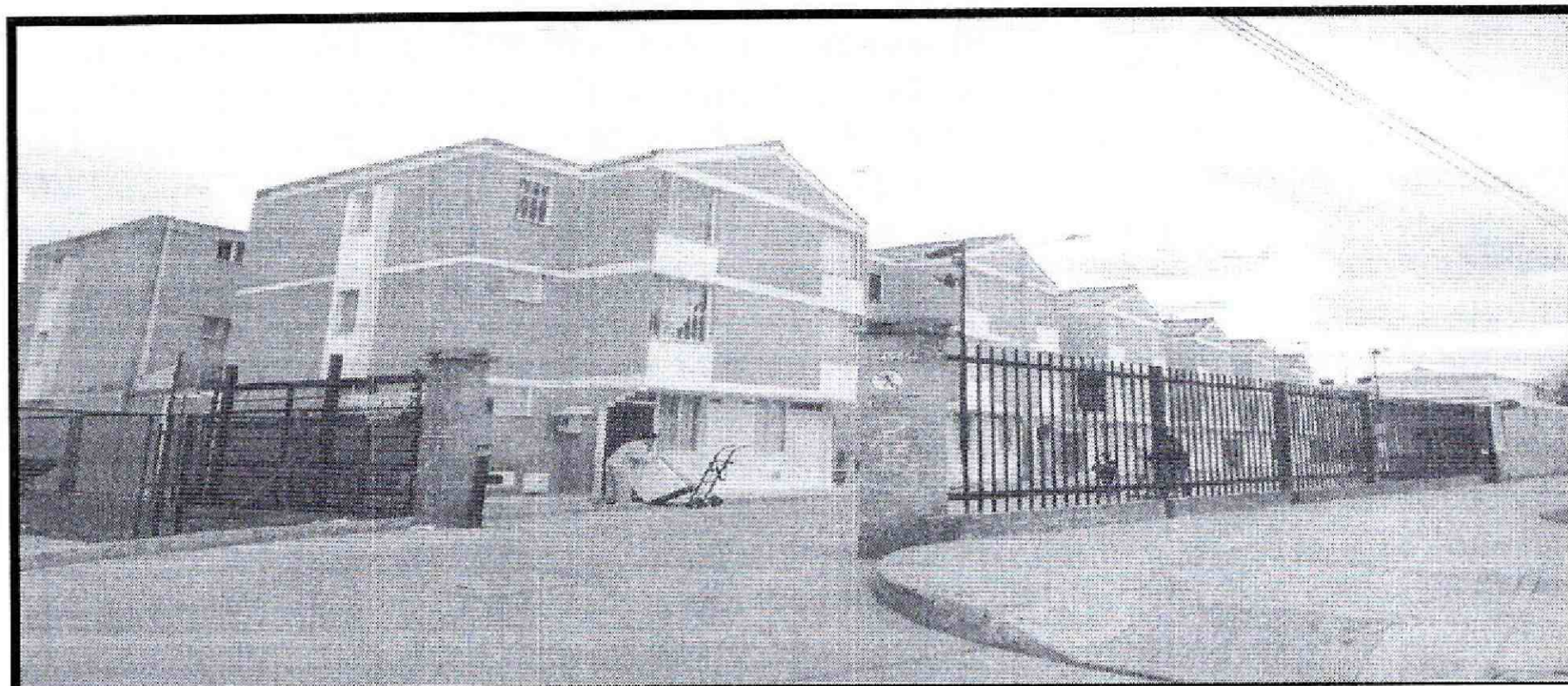
Fotografía 1. Vista general del Conjunto Residencial Agrupación de Vivienda Compartir La Margarita, en el Sector Catastral La Margarita, de la Localidad de Kennedy.
