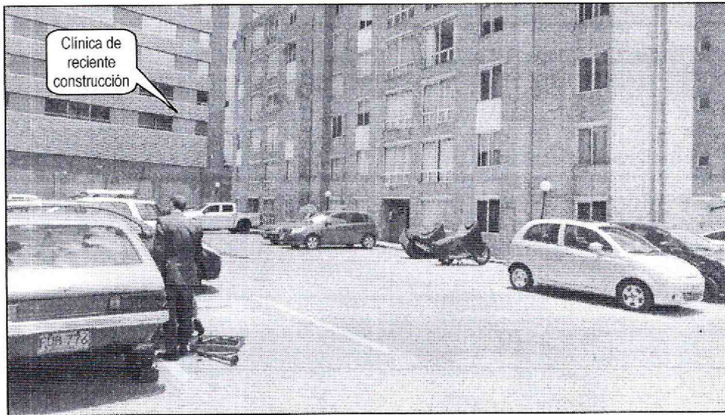
Fotografía 2. Fachada interior del bloque 3 del Conjunto Residencial Arboleda Real emplazado en la Carrera 73 No. 163-64, en el Sector Catastral Portales del Norte, de la Localidad de Suba
