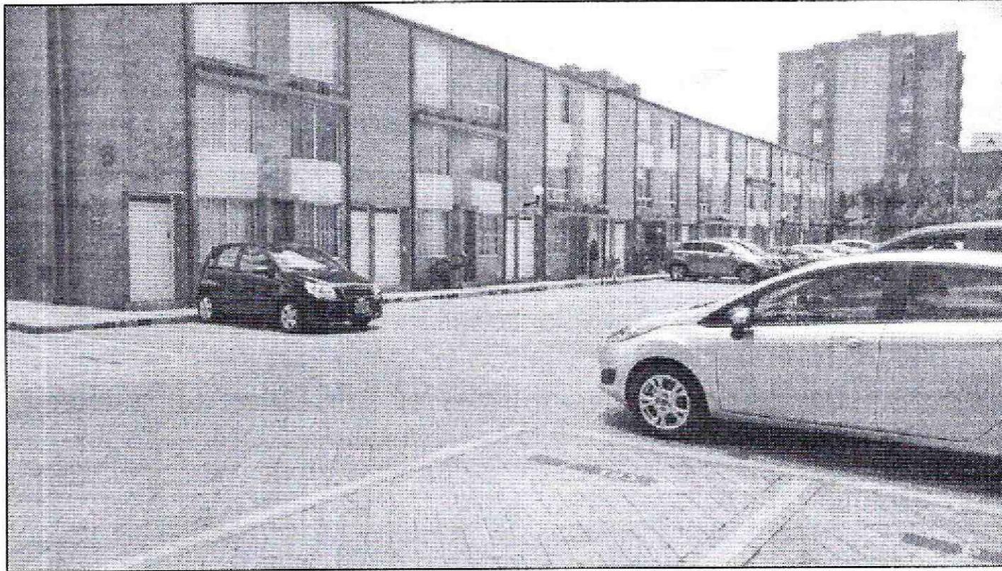
Fotografía 1. Fachada interior del bloque 6 del Conjunto Residencial Arboleda Real emplazado en la Carrera 73 No. 163-64, en el Sector Catastral Portales del Norte, de la Localidad de Suba
