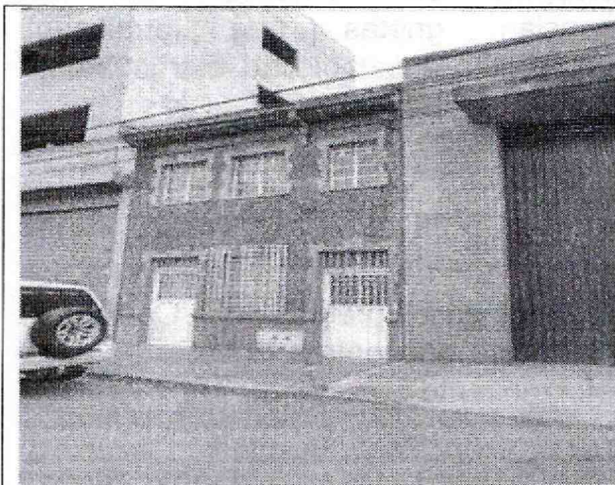
Predio de la Carrera 23 N° 76-19:
