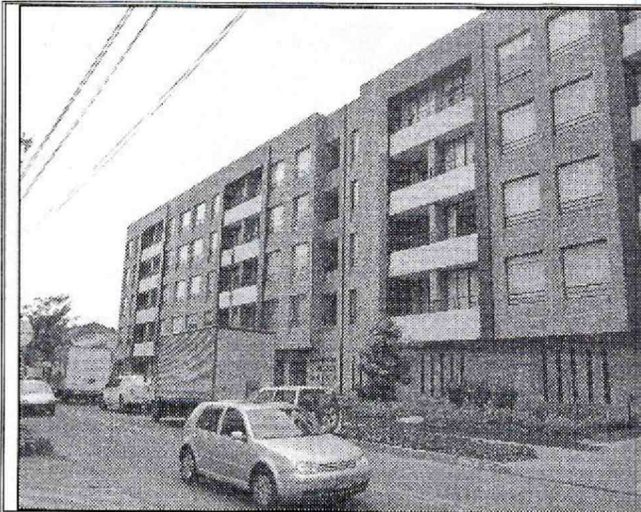
Fotografía 1. Edificio Camino de Alcalá, ubicado en el predio de la Carrera 20 No. 137-48, en el Sector Catastral Los Cedros de la Localidad Usaquén. Presenta seis (6) niveles, uno (1) para estacionamiento, cuatro (4) para apartamentos y uno (1) como zona social.
