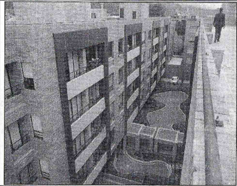
Fotografía 2. Edificio Camino de Alcalá, ubicado en el predio de la Carrera 20 No. 137-48, en el Sector Catastral Los Cedros de la Localidad Usaquén. Presenta seis (6) niveles, uno (1) para estacionamiento, cuatro (4) para apartamentos y uno (1) como zona social.
