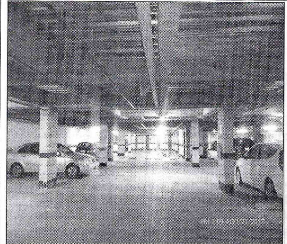
Fotografía 3. Zona de estacionamiento de vehículos ubicada en el primer nivel del edificio Camino de Alcalá, ubicado en el predio de la Carrera 20 No. 137-48, en el Sector Catastral Los Cedros de la Localidad Usaquén.
