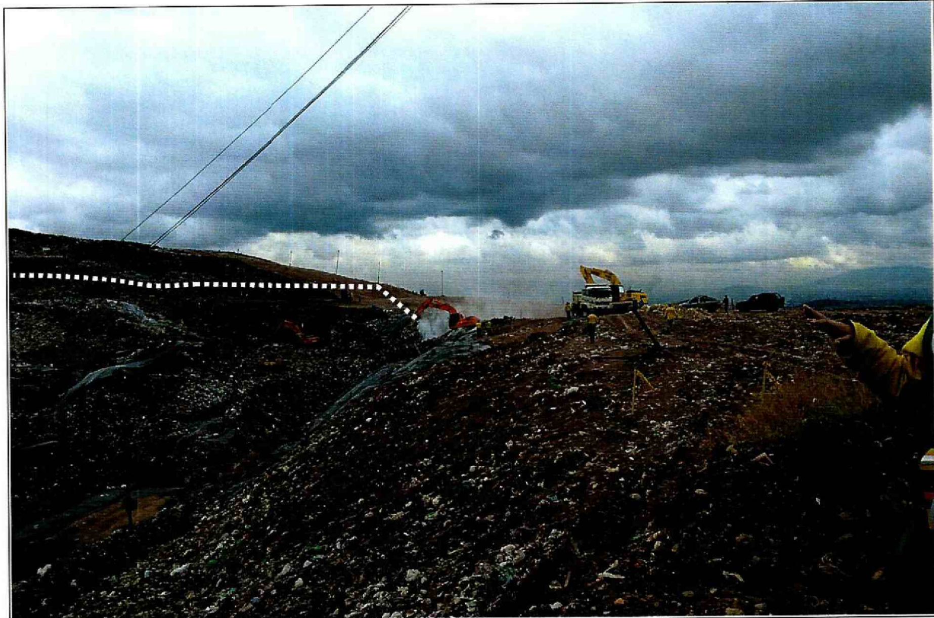
Fotografía 4. Conformación de taludes de corte y/o relleno de tendencia subvertical.
