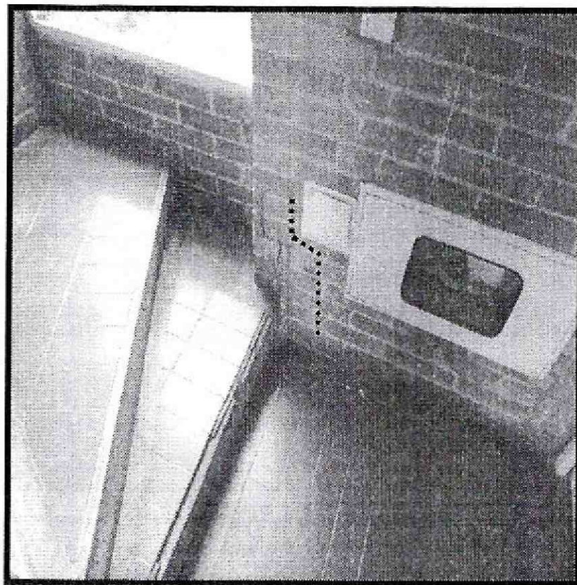
Fotografías 9 y 10. Fisuras en los muros de mampostería, que conforman las áreas comunes donde se encuentra la escalera en el interior 5 del bloque 5 en el Conjunto Residencial Agrupación de vivienda Pio XII.
