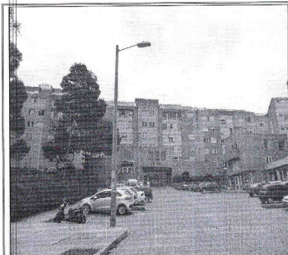
Fotografía 1. Conjunto residencial Bosques de la María II, en el Sector Catastral Horizontes Norte de la Localidad Usaquén. Se observan las torres de apartamentos, las cuales cuentan con seis (6) niveles de apartamentos y (1) nivel para estacionamiento de vehículos.
