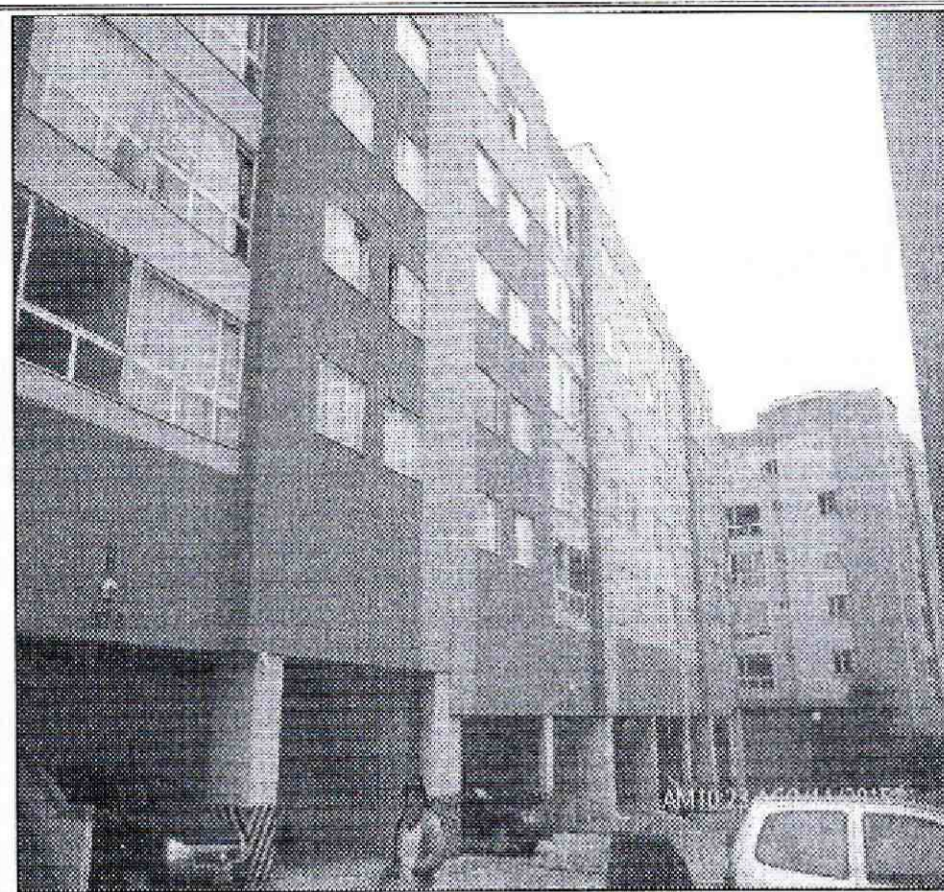
Fotografía 2. Conjunto residencial Bosques de la María II, en el Sector Catastral Horizontes Norte de la Localidad Usaquén. Se observan las torres de apartamentos, las cuales cuentan con seis (6) niveles de apartamentos y (1) nivel para estacionamiento de vehículos.
