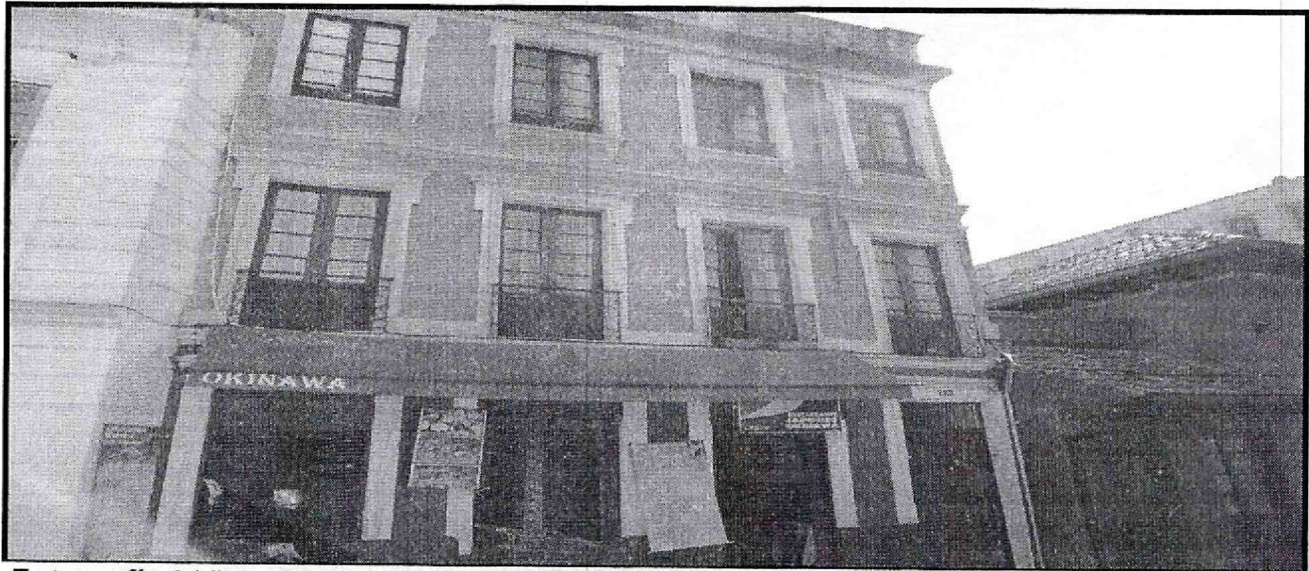
Fotografía 2. Vista general desde de la fachada principal del predio de la Calle 9 No 6-25, en el Sector Catastral Centro Administrativo, de la Localidad de La Candelaria.
