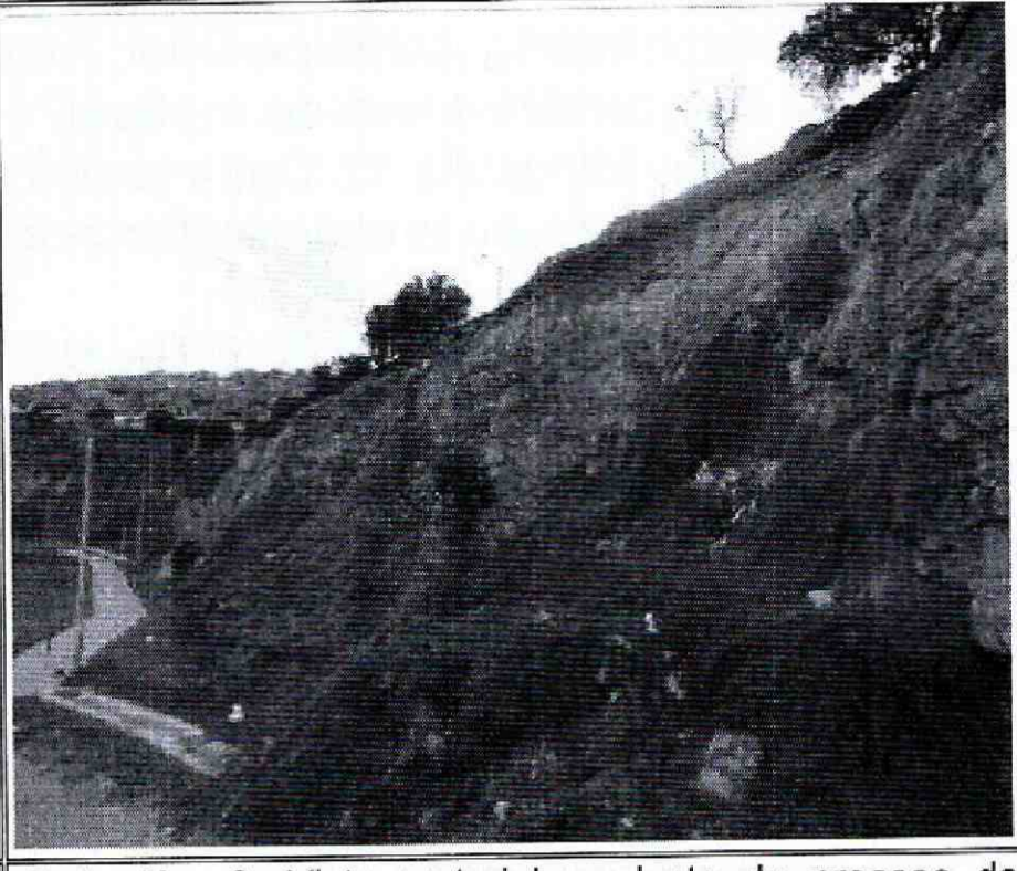
Foto No. 3. Vista material producto de proceso de remoción en masa sobre sendero peatonal del sector
