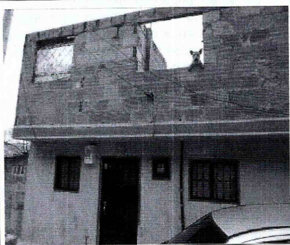
Foto No. 4. Vista frontal del predio de la Transversal 20 D Bis A No. 68 K - 36 Sur
