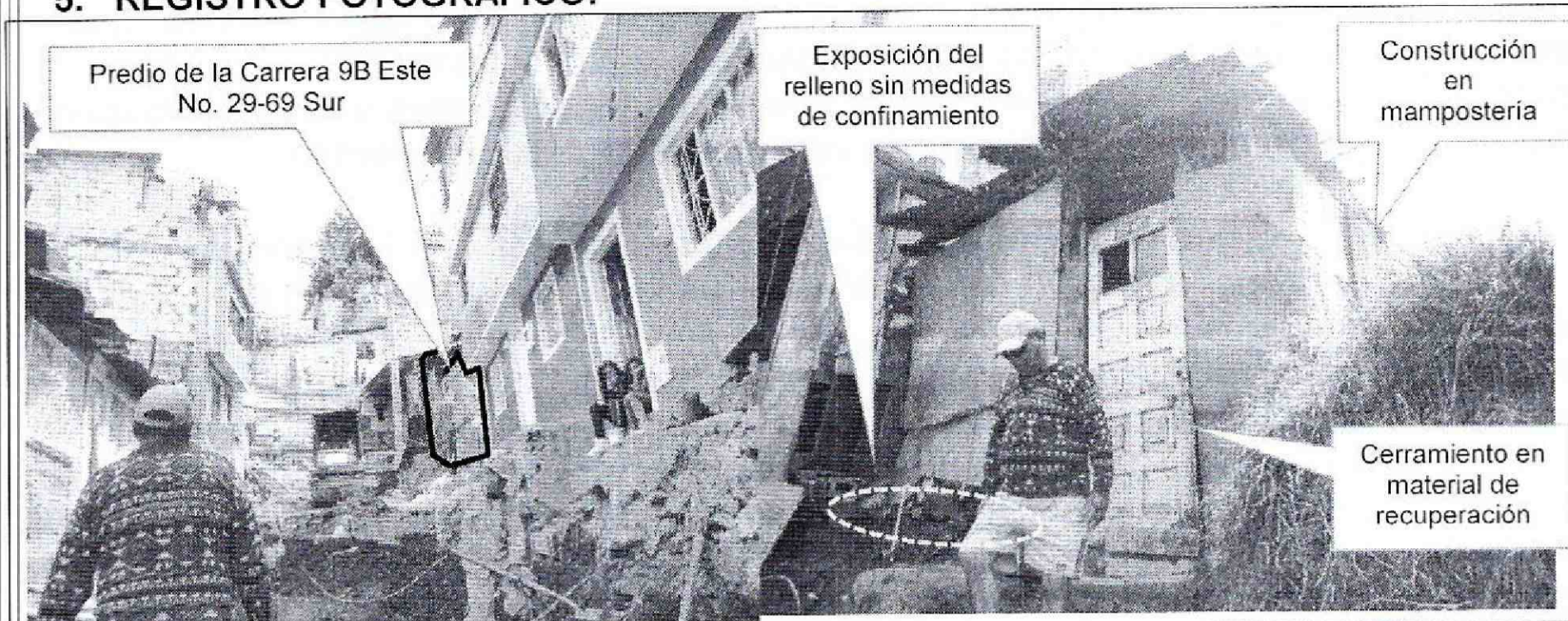
Fotografía 1. Vista de la vía Carrera 9B Este y las obras de pavimentación, al fondo, el predio de la Carrera 9B Este No. 29-69 Sur, en el Barrio El Ramajal (San Pedro) de la Localidad de San Cristóbal.
