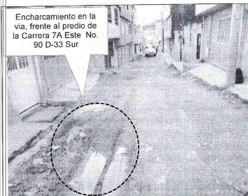
Fotografía 3. Encharcamiento en el sitio del hundimiento y vista de la vía Carrera 7 A Este, en sentido sur- norte
