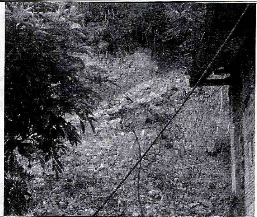
Foto No. 10. Desprendimiento de cobertura vegetal, de la ladera del costado oriental en la vivienda No. 3, de la Carrera 10 D Bis Este No. 81 C – 16 Sur.
