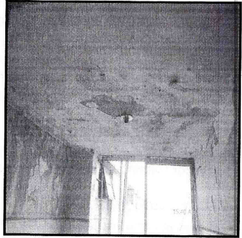
Fotografías 15 y 16 Aparición de humedades en el acabado de muros y cielorrasos al interior de los apartamentos del predio ubicado en la Carrera 26 No 52 A 35, en el Sector Catastral Galerías, de la Localidad de Teusaquillo
