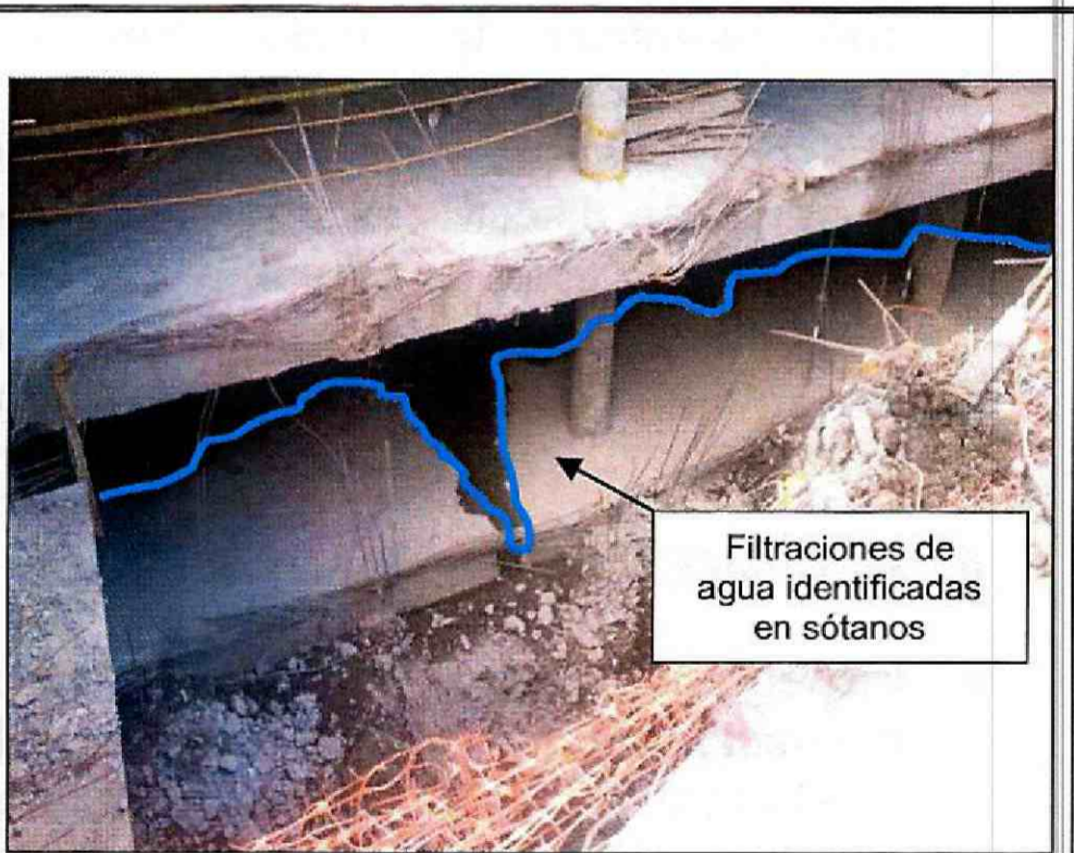
Fotografía 6. Anillos de rigidización implementados en el proyecto Elemento ubicado en el predio de la Avenida Calle 26 No. 69-76, en el sector catastral Jardín Botánico de la Localidad Engativá. Se observa el retiro de suelo a fin de generar el cuarto sótano del proyecto elemento, en la zona occidental del predio.
