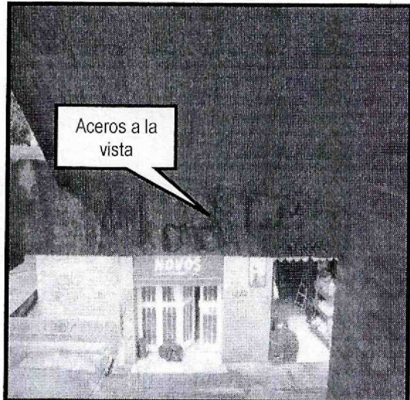
Fotografías 16 y 17. Aceros de refuerzo sin recubrimiento en la placa de descanso de la escalera del costado norte.
