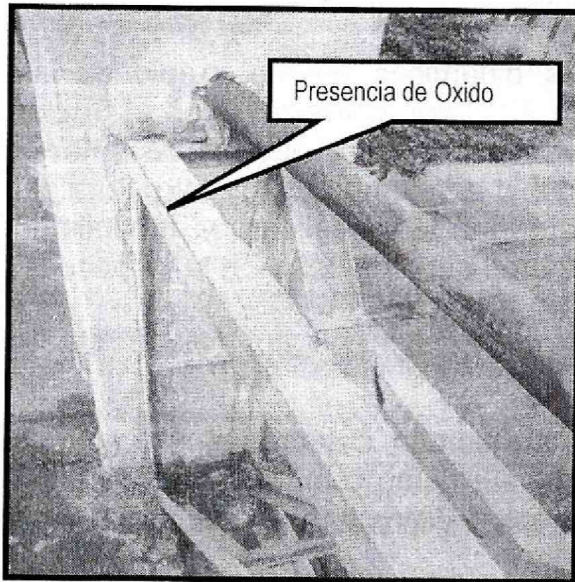
Fotografías 26 y 27. Presencia de oxido en los elementos metálicos como en las barandas y cerchas que conforman la estructura metálica del puente peatonal.
