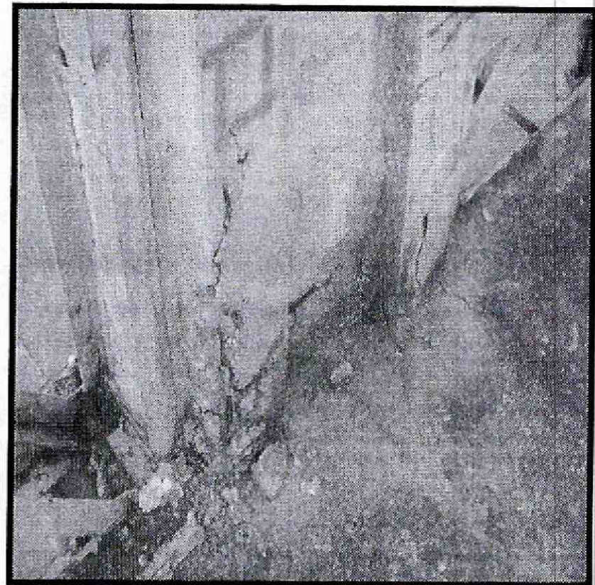
Fotografías 21 y 22. Columna que presenta desprendimientos del recubrimiento al nivel de la placa de concreto por donde circulan los usuarios del puente peatonal.
