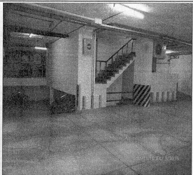
Fotografía 2. Vista de los sótanos de estacionamiento del Edificio Alcaraván, ubicado en el predio de la Calle 106 No. 7-60, en el sector catastral Santa Ana Occidental de la Localidad Usaquén.
