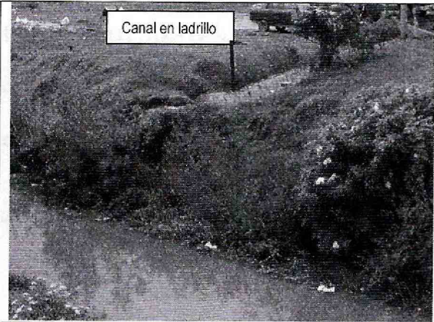
Fotografías 3 y 4. Talud de corte margen izquierdo aguas abajo de la Quebrada Limas, empradizado con pasto kikuyo y canal en ladrillo, para vertimiento de aguas residuales, en el sector del Barrio Arborizadora Baja, de la Localidad de Ciudad Bolívar.
