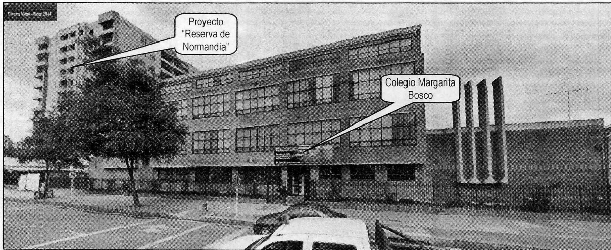
Fotografía 1. Fachada principal del Centro Comercial de Educación Media Margarita Bosco ubicado en la Avenida Calle 63 No. 73A-44 del Sector Catastral El Encanto de la Localidad de Engativá
