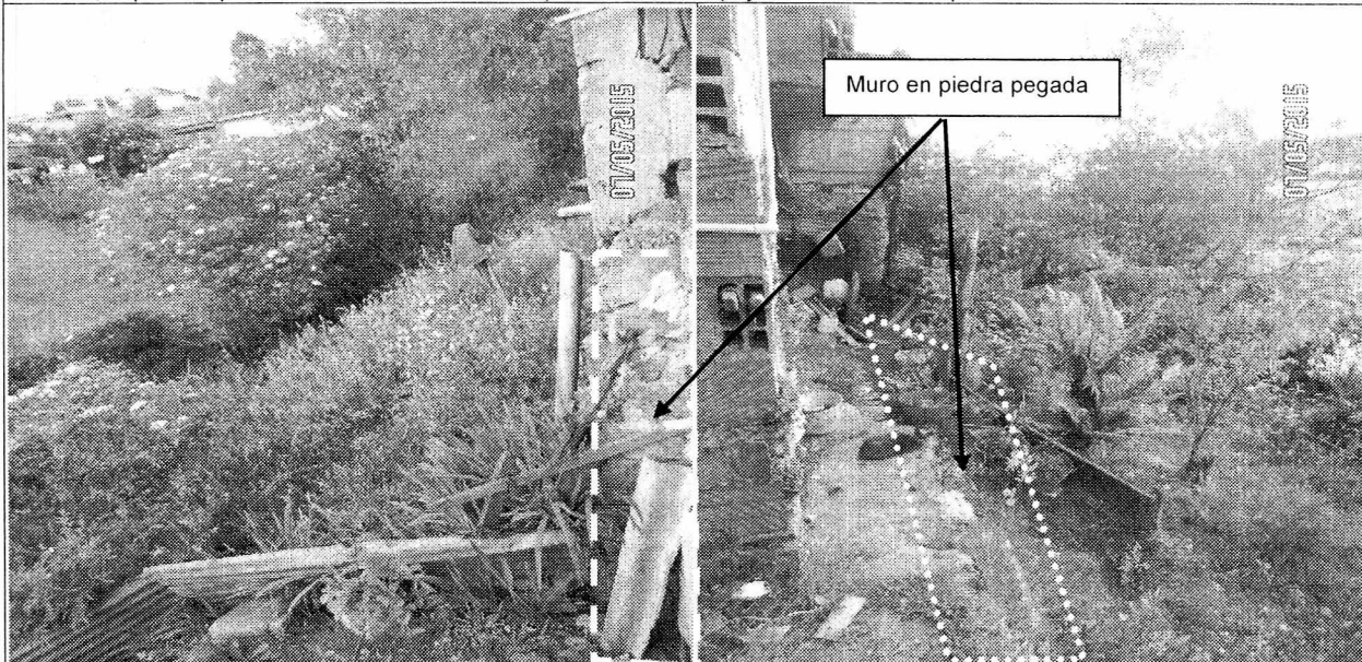
Fotografía 1 y 2. Vista del talud realizado para la adecuación del predio de la Calle 76 Sur No. 12-62 Este y posterior emplazamiento de la vivienda allí existente (localizado por debajo del nivel de la cota de rasante de la Calle 76 Sur), en el que se implementó como medida de contención un muro en piedra pegada.
