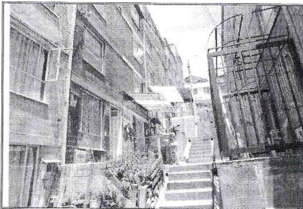
Foto No. 1. Aspecto de las viviendas emplazadas en el predio de la Diagonal 62H Bis Sur No. 74A - 53, Conjunto Residencial Altos de Galicia, de la Localidad de Ciudad Bolívar.
