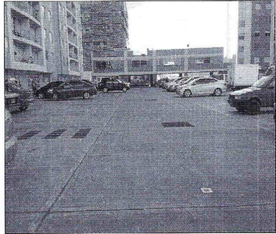
Fotografía 2. Vista del estacionamiento sobre plataforma del conjunto residencial Parque de los Cerezos 1ª y 2ª Etapa, ubicado en el predio de la Calle 137 No. 91-97, en el sector catastral Villa Elisa de la Localidad Suba.
