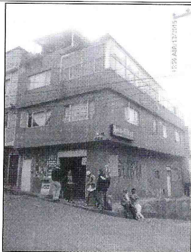
Fotografía 1. Vista de la vivienda emplazada en el predio de la Carrera 4B No. 51C-05 Sur, Desarrollo La Paz de la Localidad de Rafael Uribe Uribe.
