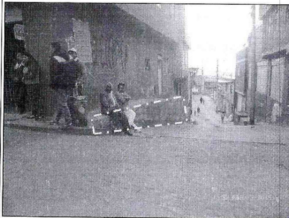
Fotografía 2. Vista del muro de confinamiento en mampostería implementado al costado sur del predio de la Carrera 4B No. 51C-05 Sur, en el que al momento de la inspección visual no se identificó ningún tipo de daño que indique compromiso en su estabilidad estructural.
