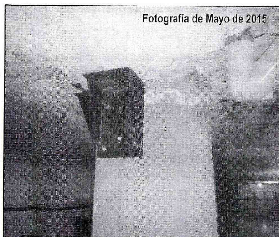
Fotografía 7 y 8. Vista de una de las platinas instaladas en columnas y de los apuntalamientos metálicos en el sector de depósitos del sótano del Edificio Torreladera 145 P.H. ubicado en la Carrera 13 No. 145-45 del Sector Catastral Acacias Usaquén de la Localidad de Usaquén
