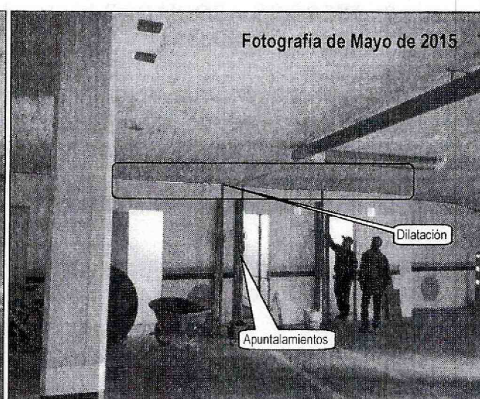
Fotografía 7 y 8. Vista de una de las platinas instaladas en columnas y de los apuntalamientos metálicos en el sector de depósitos del sótano del Edificio Torreladera 145 P.H. ubicado en la Carrera 13 No. 145-45 del Sector Catastral Acacias Usaquén de la Localidad de Usaquén
